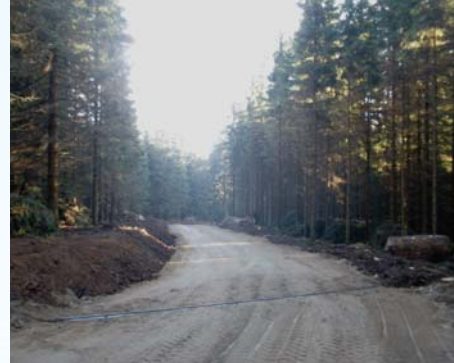
Rozšířený výjezd z lyžařského stadionu v Bedřichově
